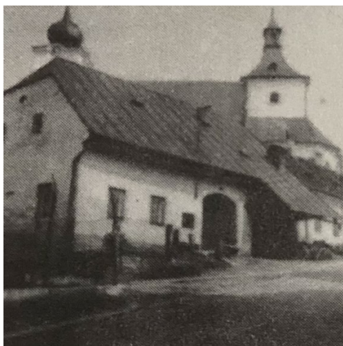
obr. 6 – budova bývalé kovárny Františka Javorského, foto z poloviny 20. století zdroj: rodinný archiv
